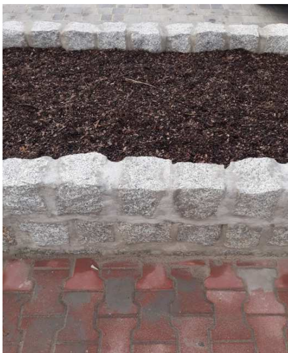
Rys.2 Przykład murku oporowego z granitu
